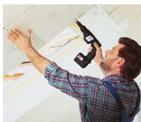
Sausā apmetuma plākšņu piestiprināšana
